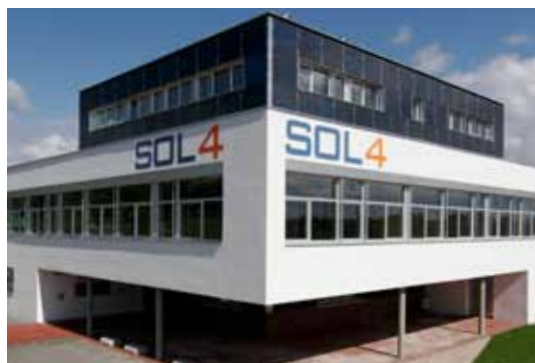
Sol 4: eine Pionierleistung für innovatives und ökologisches Bauen
